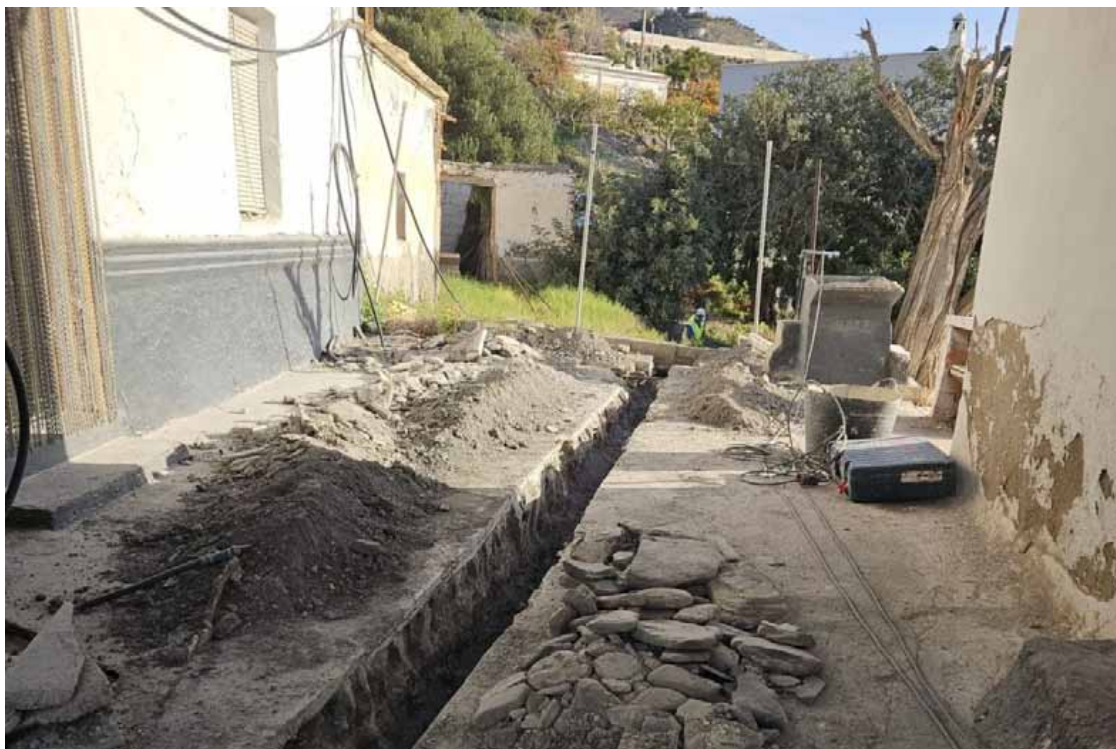
Zanja de la nueva tubería en Melicena | Foto: Gabinete
