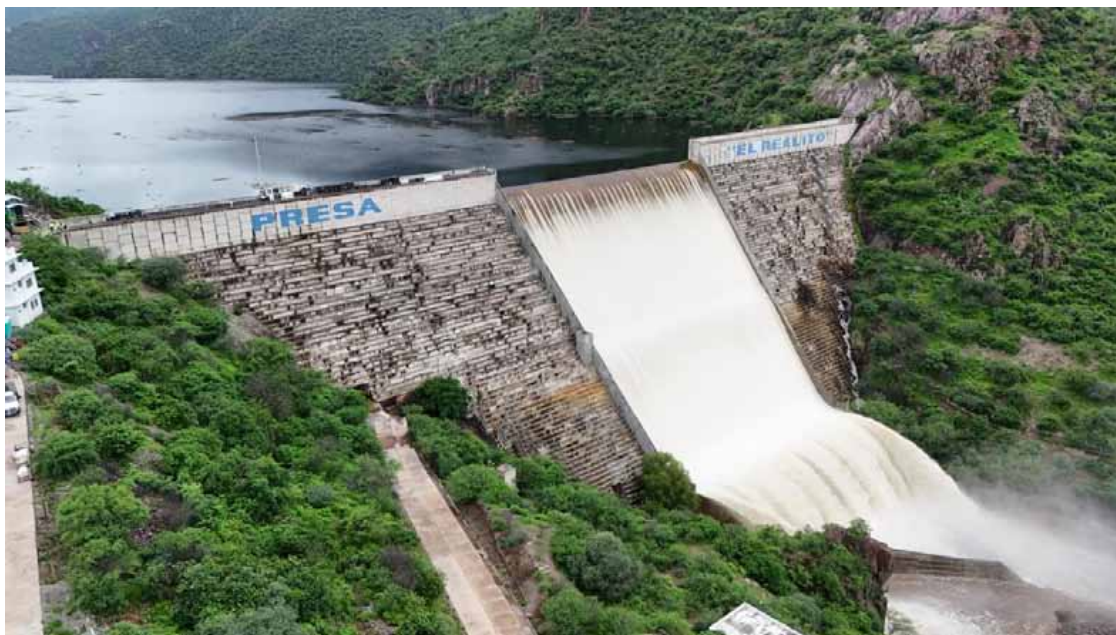
Presa el Realito
