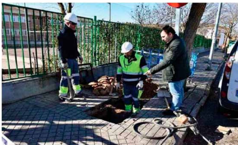
Operarios en una obra para la renovación de la red en la localidad. / LT
