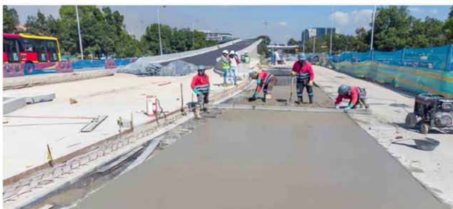
Entre las obras que hemos entregado este año está el puente de la Avenida 68 sobre la 26.
